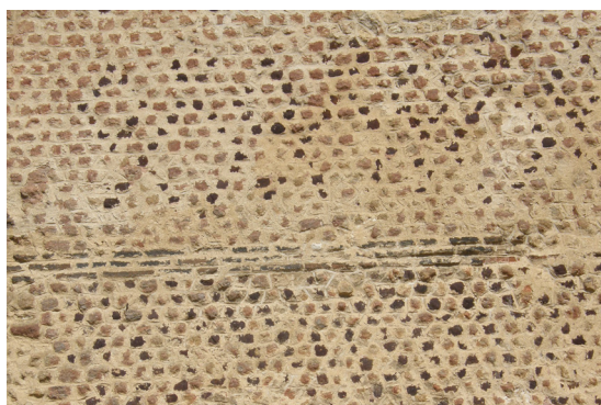
le mur romain de l'église du 3 ème façade sud
